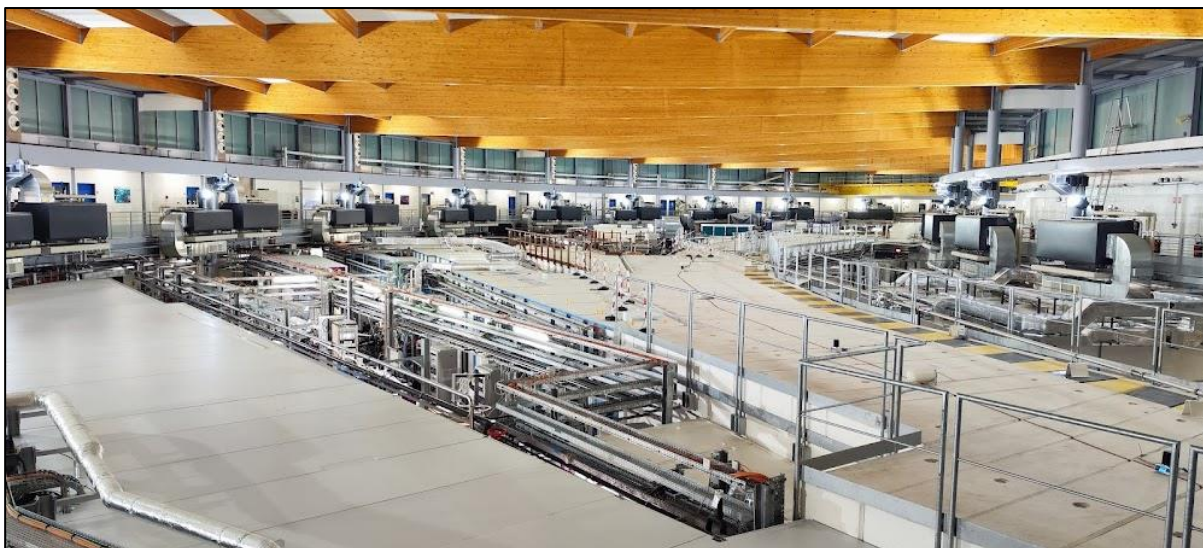
Titre : Image de l'intérieur de l'anneau où se situe le synchrotron, on voit au 1 er plan des cabines de lignes de lumières vues du dessus
